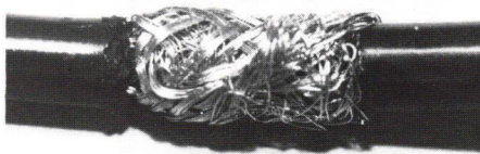
Afb. 10. Nadat de afschermingen over elkaar zijn geschoven kan isolatieband worden aangebracht, zodat geen enkel stukje afscherming nog buiten de kabel contact kan maken.
